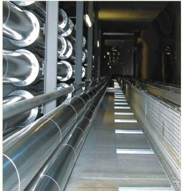
K-FLEX ST AL CLAD SYSTEM 시공사례
